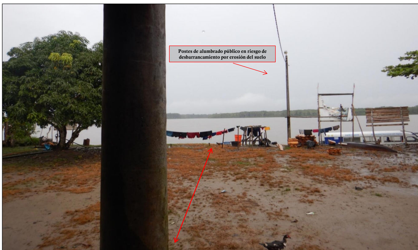
FIGURA N°03: ESTRUCTURAS DE SERVICIO ELÉCTRICO AFECTADOS POR LA EROSIÓN DE SUELO E INUNDACIONES.
